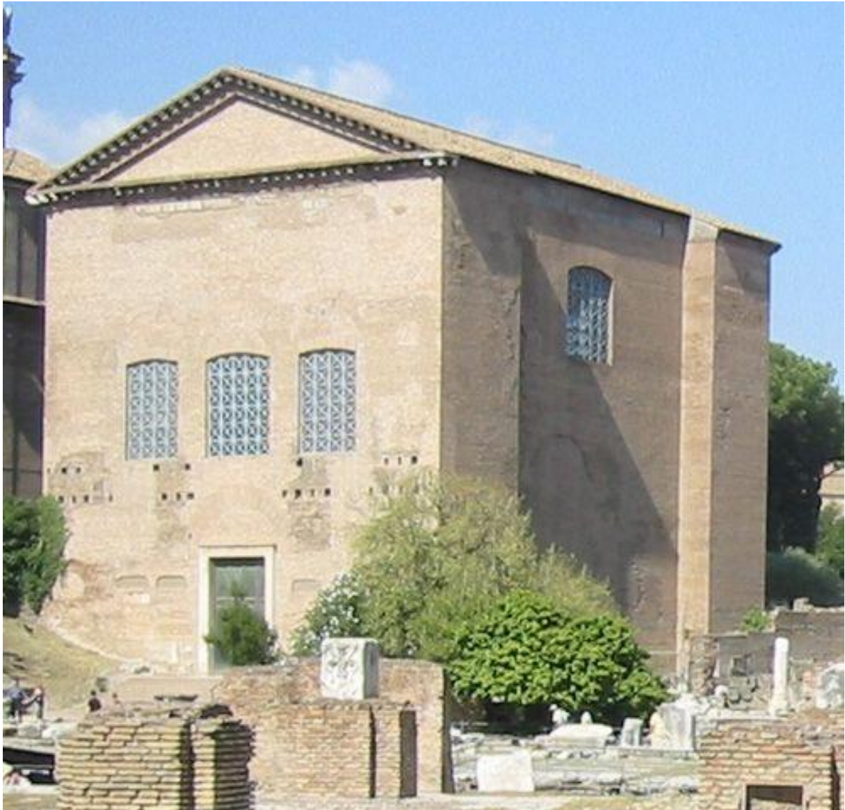
Senatens byggnad på Forum i Rom.
